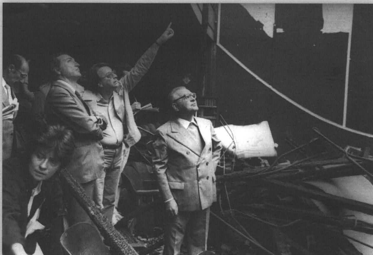
Dom Paulo vistoria pessoalmente os escombros do incêndio no TUCA. Terá sido um incêndio criminoso? Do lado esquerdo, a repórter Neide Duarte.
